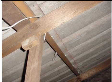
Asbestos sheet
